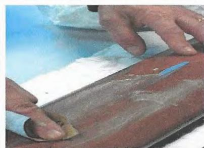
Pulizia della superficie con acqua e detersivo/shampoo. Asciugare completamente con panno morbido o panno carta . Carteggiare con passaggi in sequenza di varie tipologie di carte abrasive a secco (vedi scheda allegata) ed eventualmente ad acqua fino alla scomparsa delle incisioni della vernice lucida. Pulire e controllare l'area carteggiata con un panno carta dopo ogni passata abrasiva.
